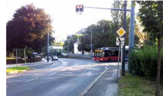
Signalregelung mit Wartezeit „Null“ und Rot-Gelb-Signalgeber („Busschleuse“ im Kreuzungsbereich Chimanistraße, Cottagegasse und Hans-Richter-Gasse, Wien)
