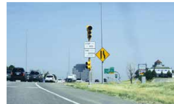
Beispiel für die Anordnung von Zwei- und Dreikammersignalgebern einer Anlage zur Zuflussdosierung in Denver, USA
